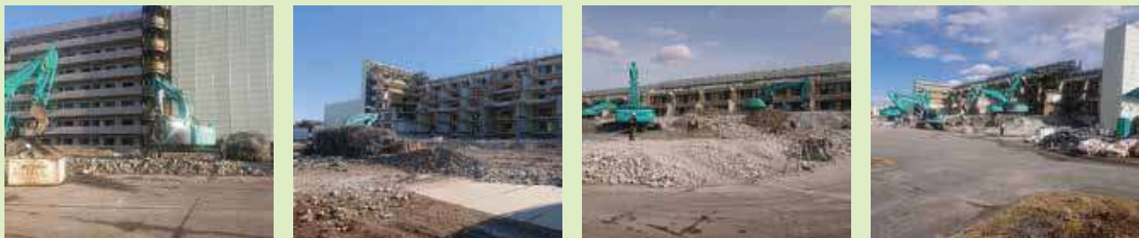
解体作業風景
