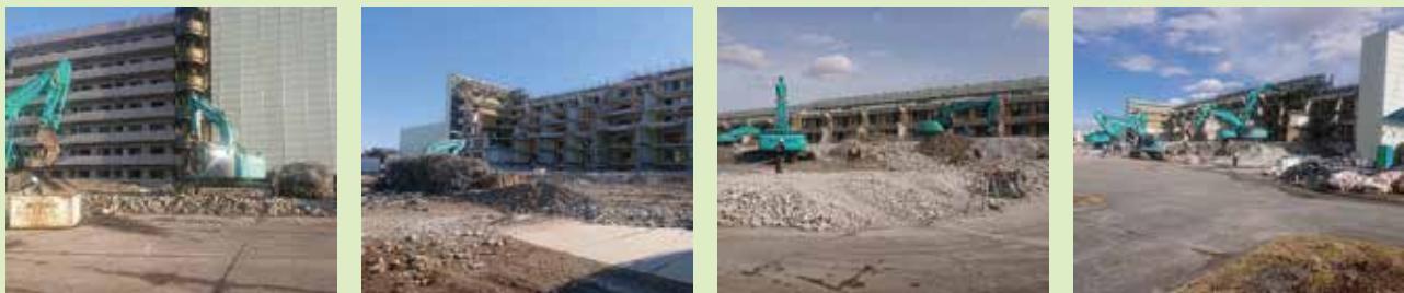
解体作業風景
