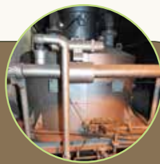
廃液濃縮装置
