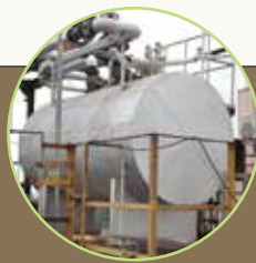
廃熱ボイラー
