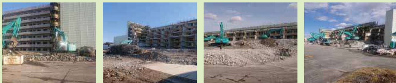
解体作業風景
